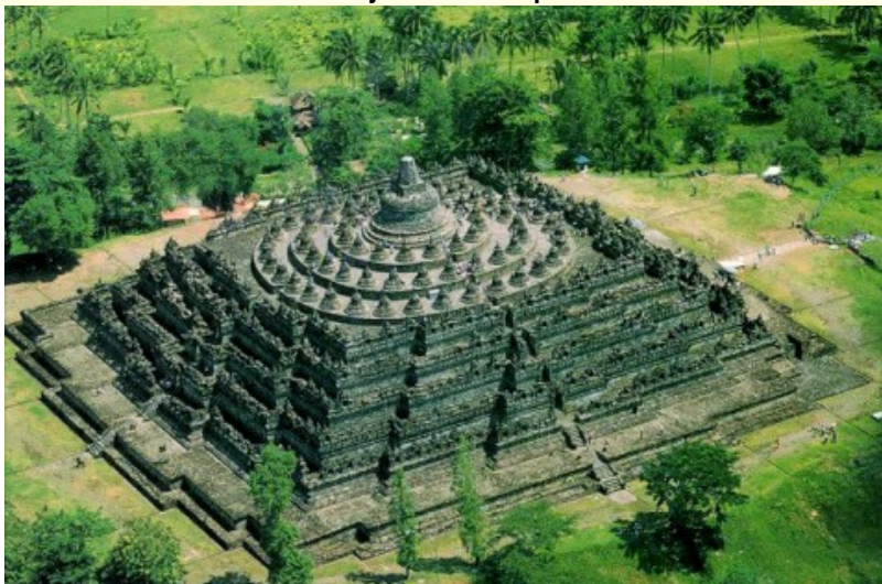
Vista Aérea do Conjunto do Templo de Borobudur
